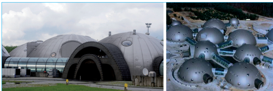
Rys. 6. Instalacja GHP AISIN w kompleksie filmowym Alvernia Studios koło Krakowa. Układ GHP Dx 290 kW
